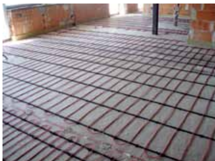
Hlavným zdrojom vykurovania je elektrické podlahové vykurovanie, na obrázku jeho realizácia v objekte
